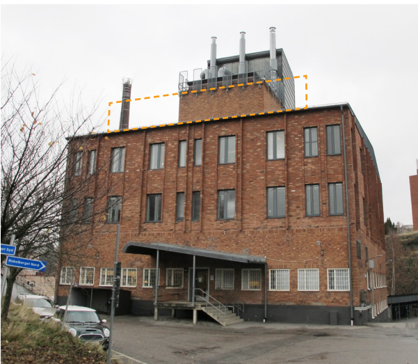
FORMALINFABRIKEN IDAG, SEDD FRÅN SÖDER
