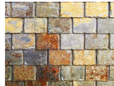
Inslag av fasadmateriäl med lager-på-lager-princip
