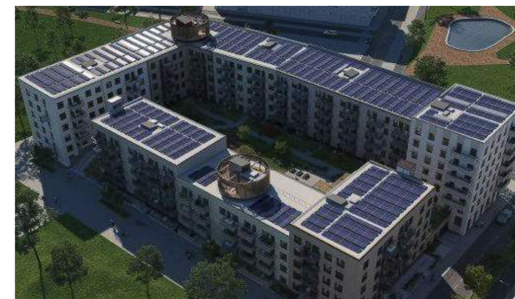
Scilla, Täby - solceller på låglutande tak
