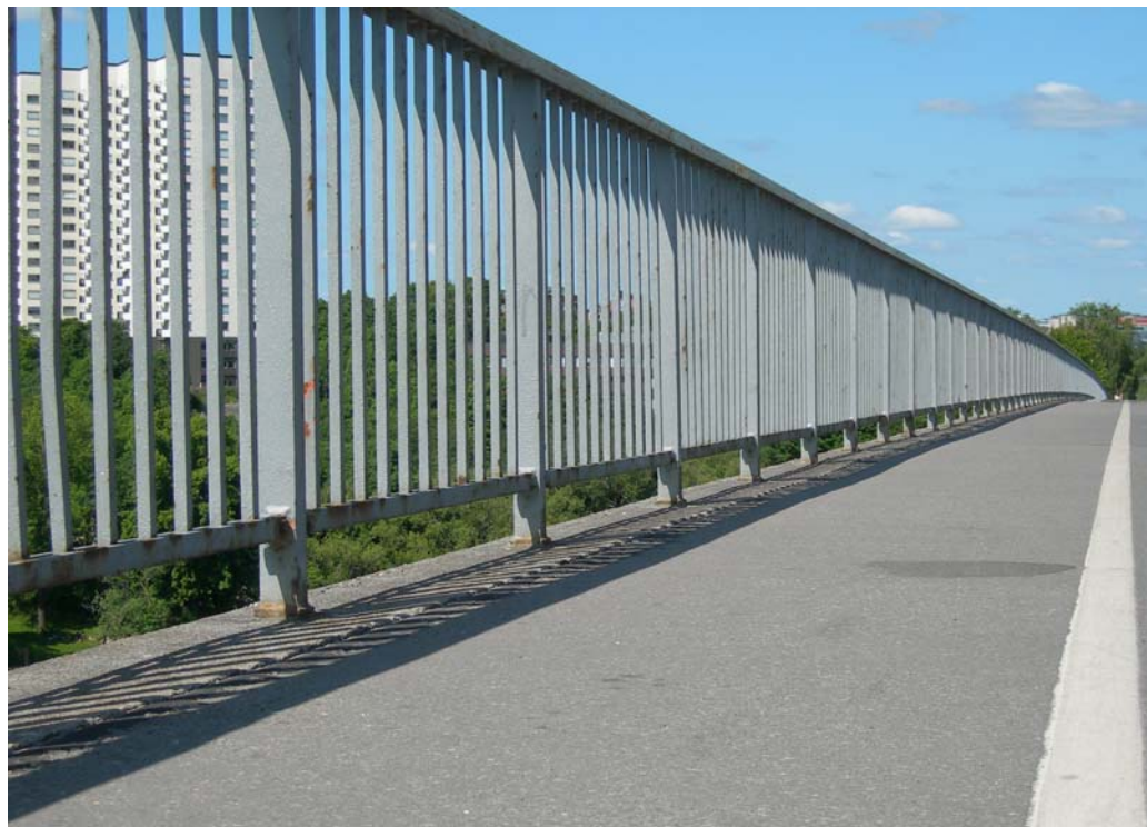
Figur 7. Kantbalk med räcke. Överytan skyddas inte mot fukt och vägsalt av ett tätskikt. De flesta kantbalkar ligger högre än vägbeläggningen. Om de inte gör det så brukar man åtgärda detta då en bro renoveras.
