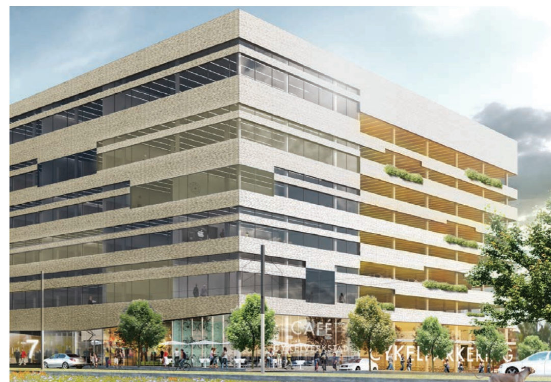
Vy 5 (Se orienteringsplan sid. 17) Söderut från Uddvägens ände mot den norra lokalgatan, fasad med öppen bottenvåning.
