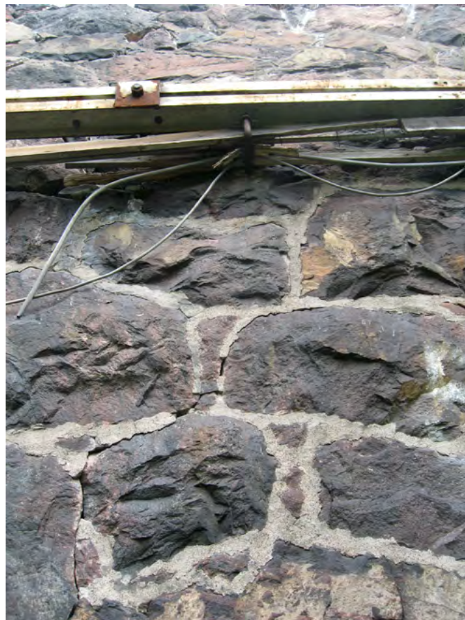
Förstärkningsbalkar av stål och spräckta fogar.
