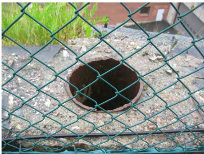
Vertikalt rör i murens ovansida.
