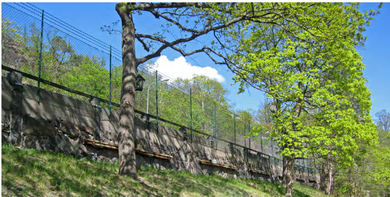
Den lägre, västra delen av muren rivs och ersätt med en betongmur.
