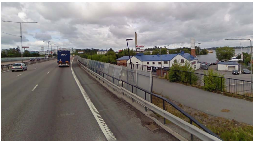
Figur 10 Exempel på cykelbana utmed stor trafikled, Södertäljevägen E 4/E 20
