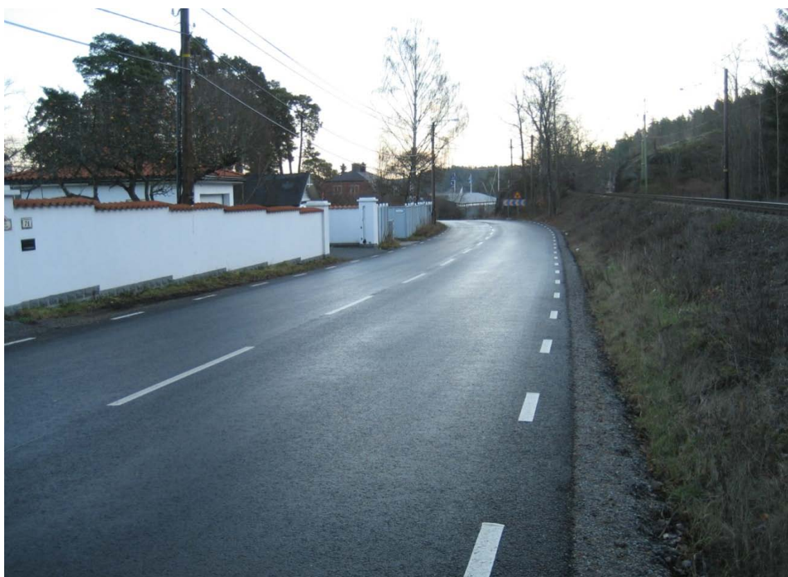
Figur 8 Murar samt Saltsjöbanan precis intill väggkanten på Saltsjöbadsvägen
