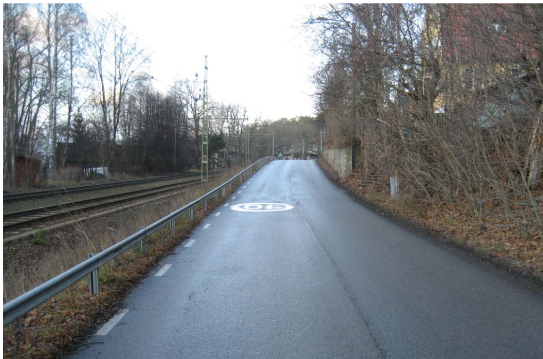
Figur 7 Saltsjöbadsvägen går mellan mur, fastigheter och Saltsjöbanan
