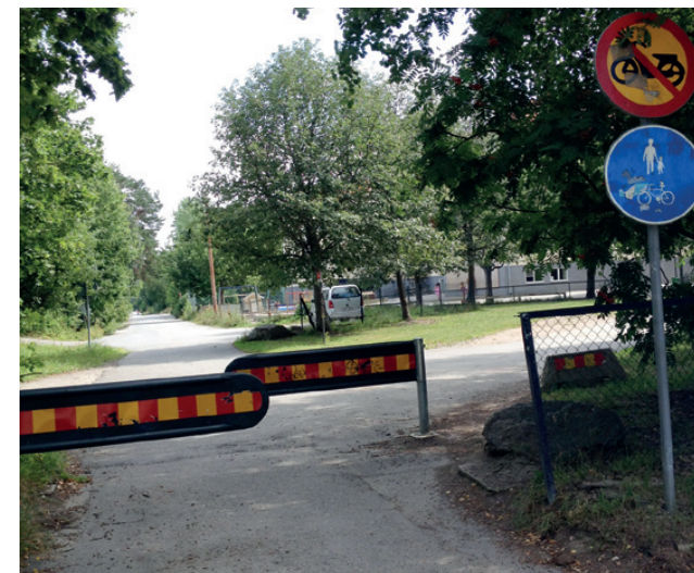
Hinder på gång- och cykelbana.
