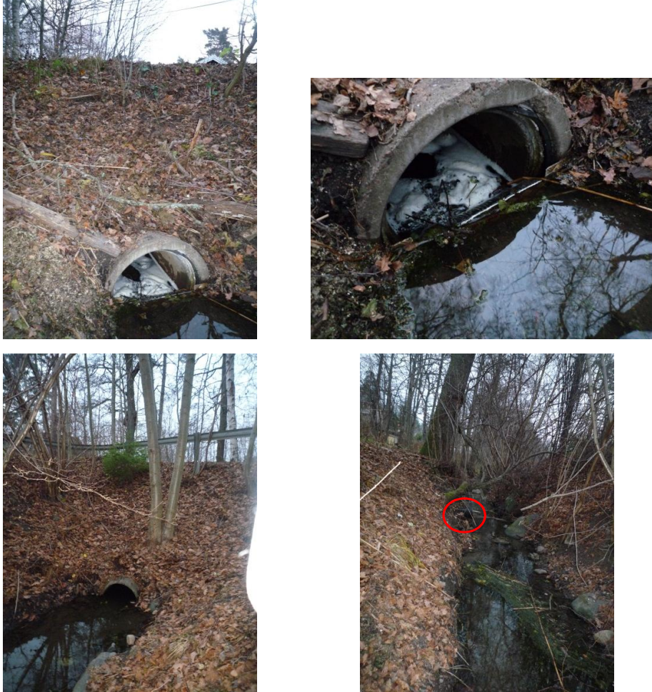
Figur 2-4 De två översta bilderna visa kulvertinloppet under Ekallén med överfallet. De två undre visar utloppet ur samma kulvert samt diket nedströms. På bilden längst ned till höger kan mynningen från en dagvattenledning skönjas, inringad.
