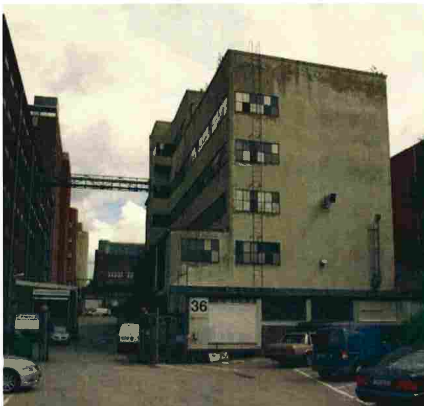
Vy mot öster. Befintligt utseende.
