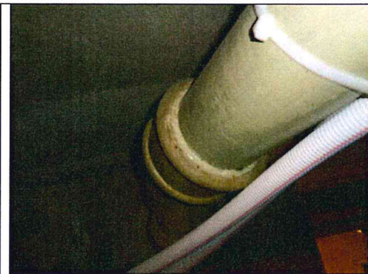
Bild 21. Äldre blydiktat avloppsrör.
