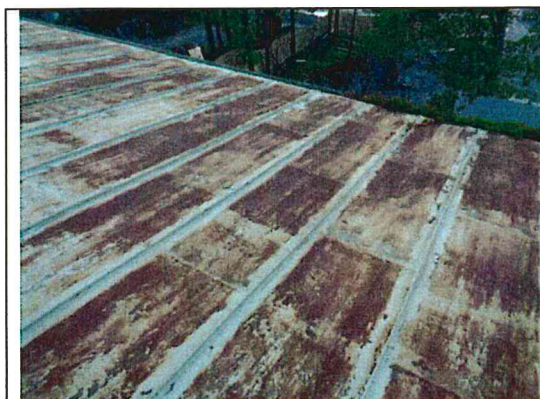
Bild 7. Korroderade takplåtar.
