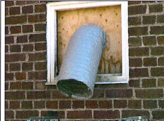
Bild 19. Ventilationskanal från köket.
