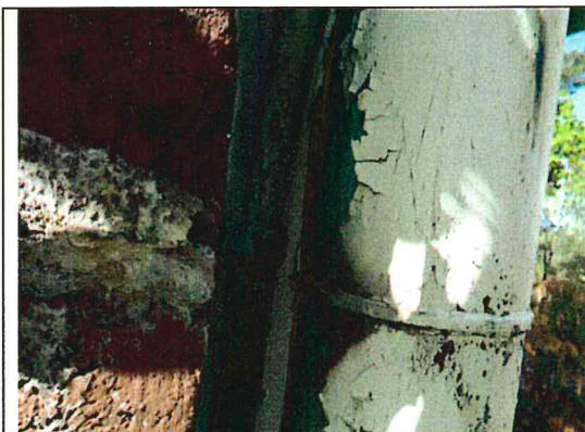
Bild 23. Korroderade avloppsrör.
