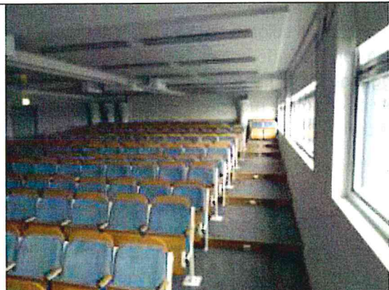
Bild 1. Sal MA22 där asbestprov tagits.
