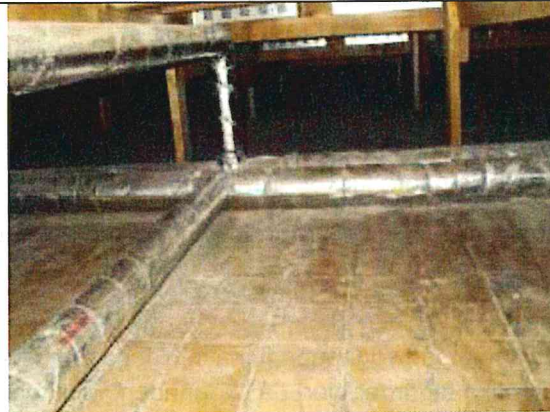
Bilder 2. Klinker plattorna under det upp stolpade golvet. En platt demolerades för att prov skulle kunna tas.
