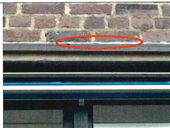
Bild 3. Fog som bedömts att det föreligger risk att innehålla PCB.
