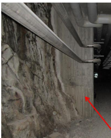
Figur 4 Betongpelare/kontrefor ihopgjuten med berget
