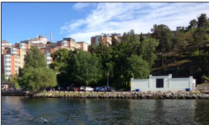
Den före detta oljekällaren med sin karaktäristiska vita fasad.
