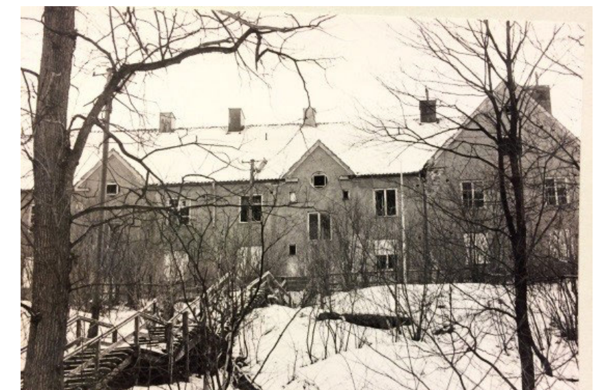
tidigare bostadsbyggnad, nu riven
