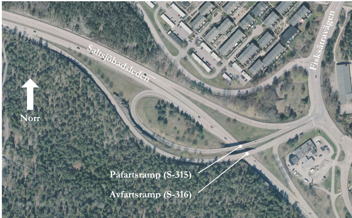
Figur 1: På- och avfartsramp vid Fisksätra trafikplats.
