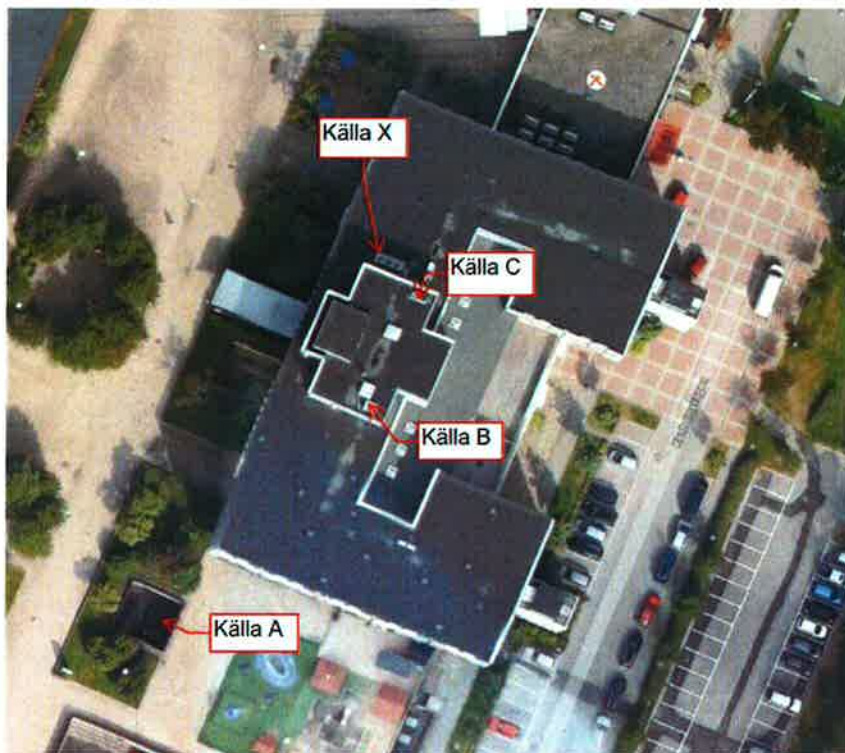
Figur 4. Vy över det västra ormingehuset med uppmätta bullerkällor.
