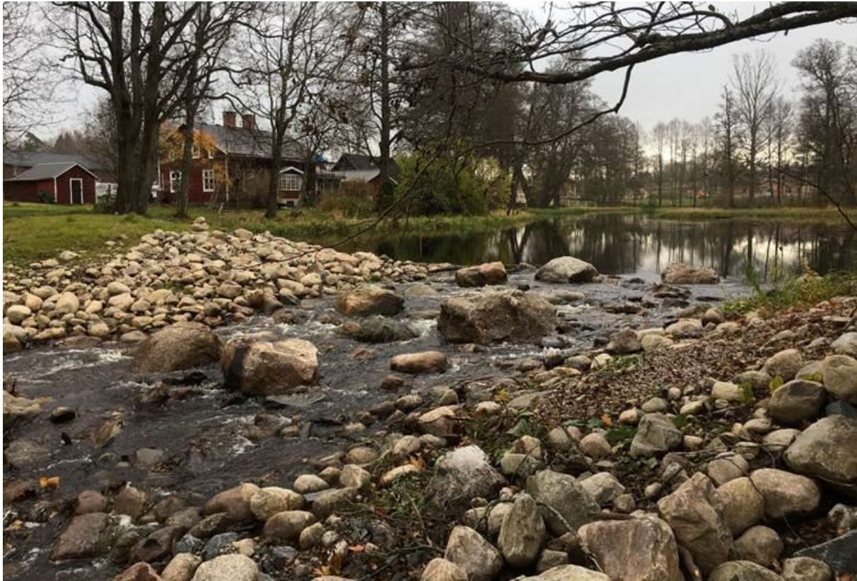
Figur 4.2. Exempel på naturliknande tröskel vid Laxån Lassåna bruk. Lägga märke till hur dämningssområdet uppströms bottenuppbyggnaden har bevarats och åtgärderna utformats så att en lågt lutande fåra skapats som säkerställer naturliga vattenståndsvariationer.
