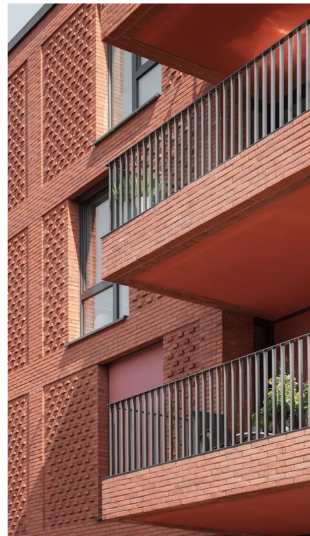
Agnes-Hundoegger-weg, Tyskland Balkonger har målade undersidor.
