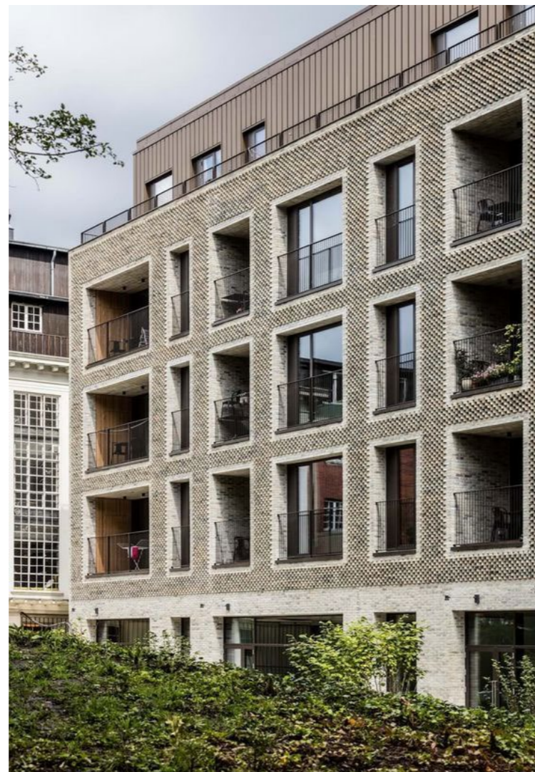
Carlsberg apartments, Danmark Tegelvariation definerar sockelvåningen.
