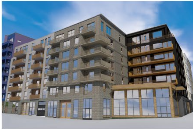
Vy från tunnelbanastations entré
