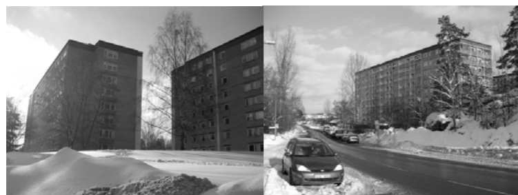
lamellhus längs Oxelvägen
