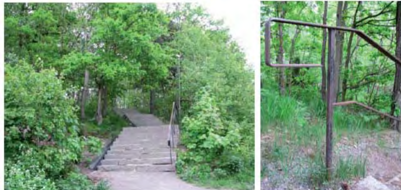
BEFINTLIG TRAPPA OCH RÄCKE
