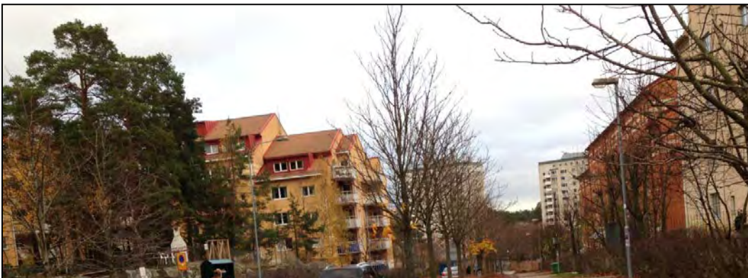
Vy över befintlig bebyggelse på Kantatvägen sett mot Per Hallströms väg
