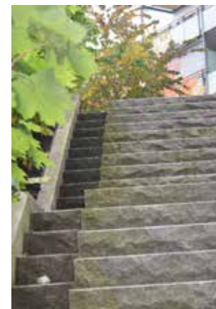
Exempel på dagvattenränna integrerat med trappa
