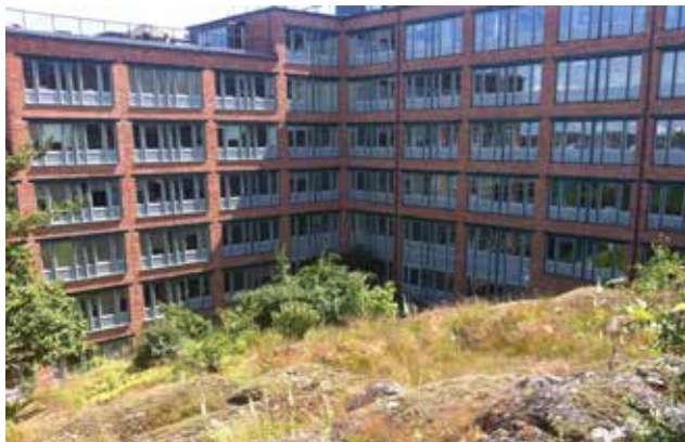
Befintlig byggnad från sjösidan
