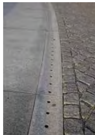
Exempel på dagvattenränna för ytlig avledning
