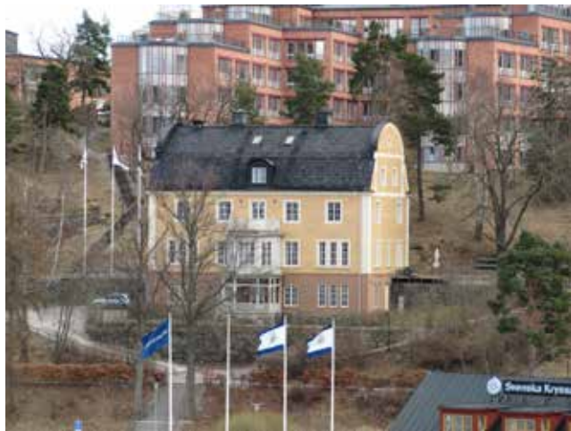
Fabrikörsvillan är en del av den gröna foten ovanför kajen. Kring huset finns miljöskapande terrassmurar och trappor.
