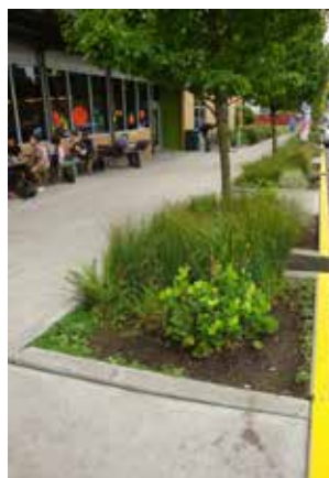
Exempel på infiltrationsyta i gaturummet.
