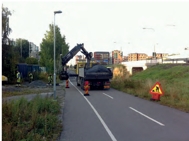
Vägarbete på gång- och cykelväg vid Sicklavägen.
