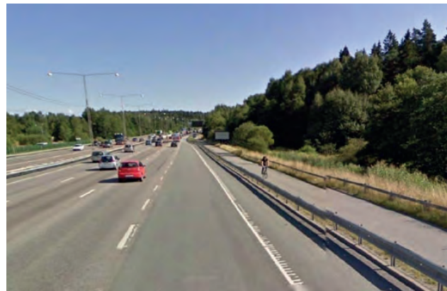
Exempel på cykelled intill E4:an vid Trafikplats Sörentorp.
