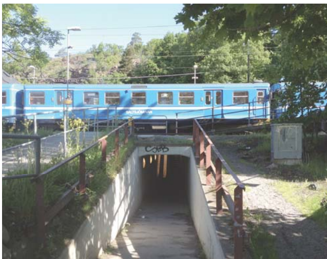
Tunnelundergången under Saltsjöbanan idag. I detta läge är förlängningen av Planiavägen är tänkta att gå.
