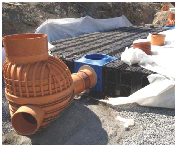
Exempel på dagvattenkassetter i Stockholm (bildkälla Sweco).
