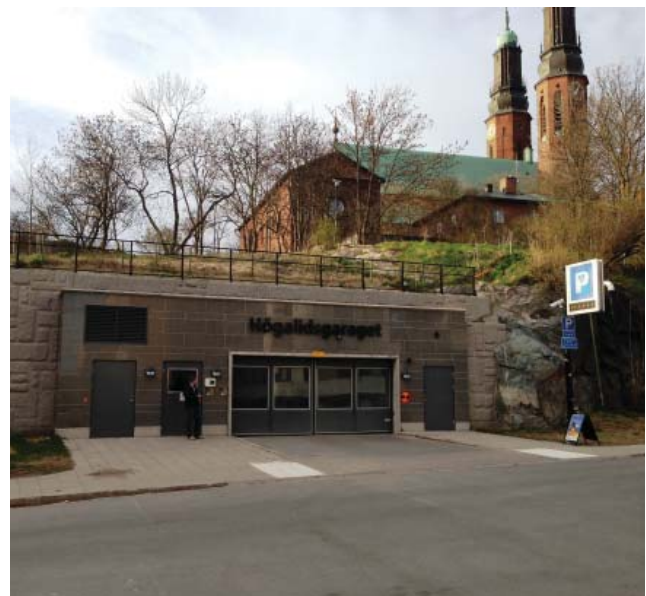
Högalidsgaraget - exempel på bergrumsgarage
