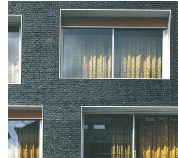
Bra exempel på hål i mur med detaljerad fönsternisch Studentboende (Claus en Kaan Architecten)
