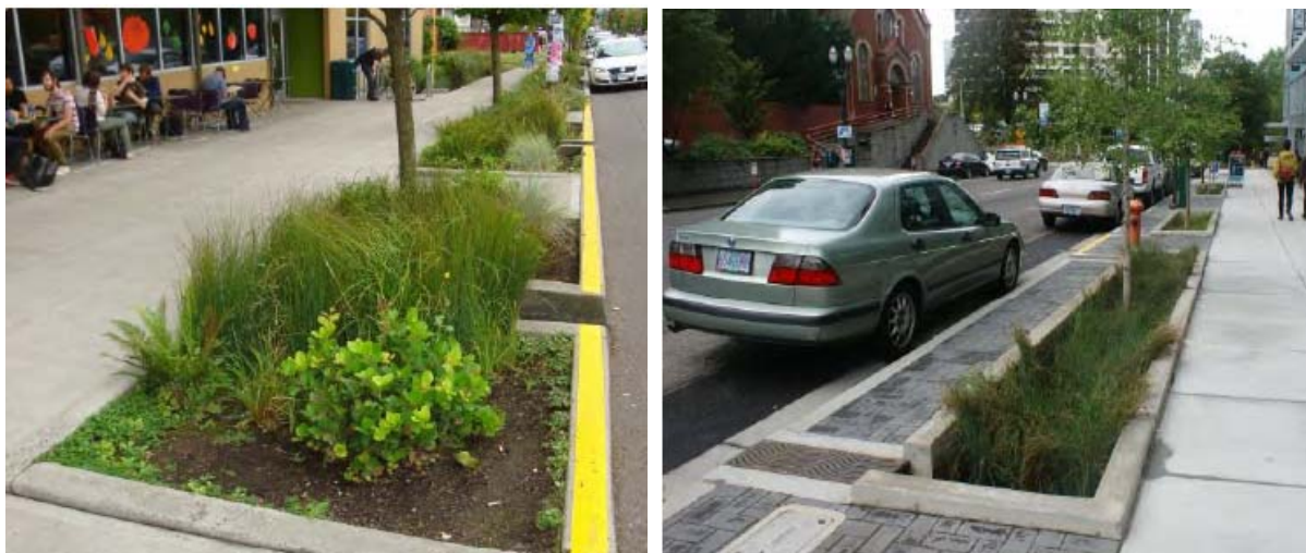
Bilder: Exempel på dagvattenhantering i gatumiljö. "Dagvattenutredning för planprogram Sicklaön" 2013-06-05; REV 2014-02-24 Sweco Environment AB
