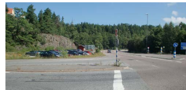
Korsningen Värmdövägen-Gamla Skärgårdsvägen byggs om till cirkulationsplats
