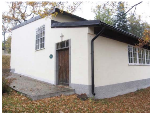
Kyrkan sydost om huvudbyggnaden. (Byggnad nummer 6)
