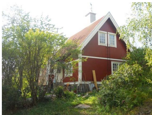
Vaktmästarbostaden strax norr om huvudbyggnaden. (Byggnad nummer 7)
