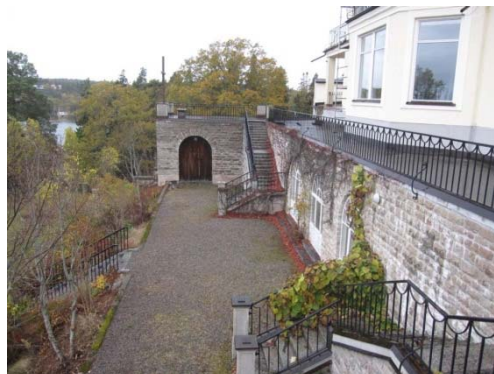
Del av terrasanläggningen. (Byggnad nummer 5)
