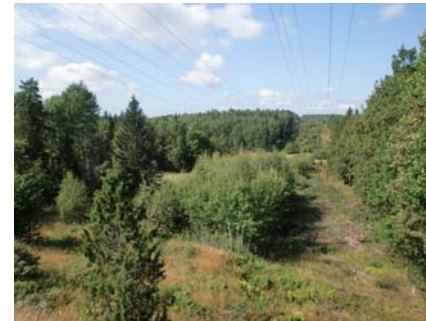
Befintlig kraftledning i västra Kil
