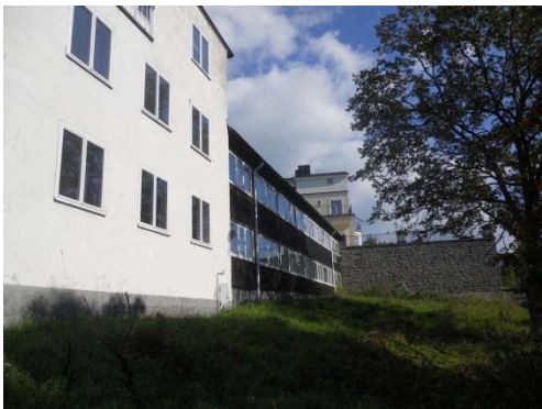
Gästhemmet i väster nås från huvudbyggnaden via en förbindelsegång i suterrängplanet. (Byggnad nummer 9)
