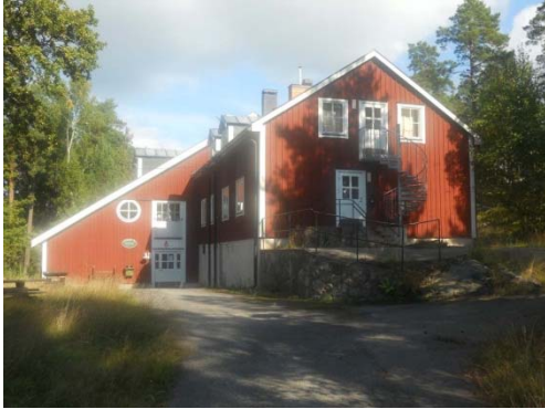
Boostugan som ligger i den nordöstra delen av fastigheten. (Byggnad nummer 1)
