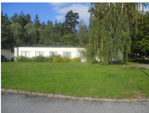
Förlägningsbyggnaden norr om gästhemmet. (Byggnad nummer 10)
