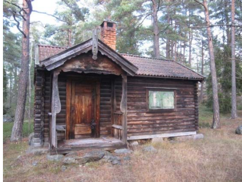
Lektugan som ligger på höjden öster om huvudbyggnaden. (Byggnad nummer 14)
