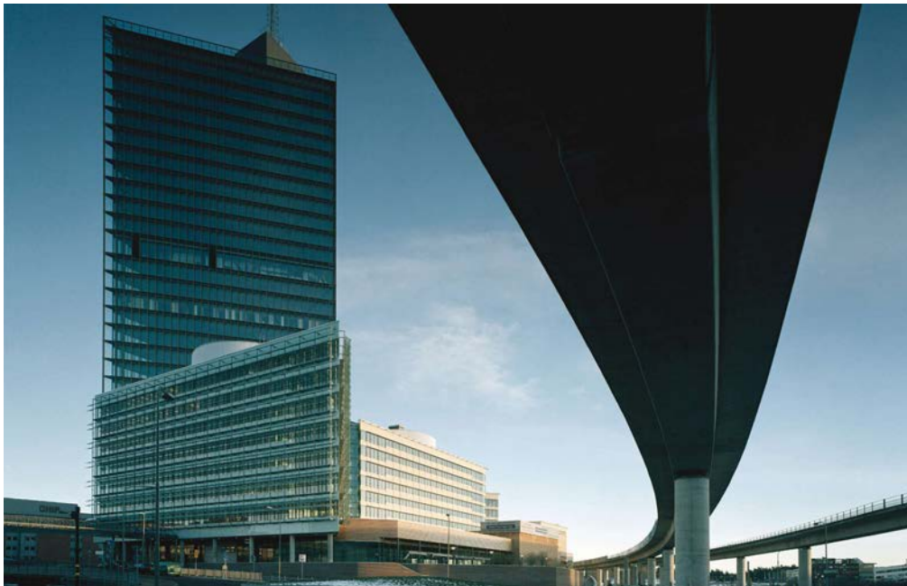
Kista Science Tower, 32 vån , 117 meter. Arkitekt: White.
