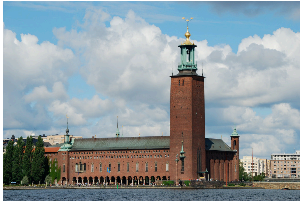
Stadshuset, 95 meter, 1923. Arkitekt: Ragnar Östberg
