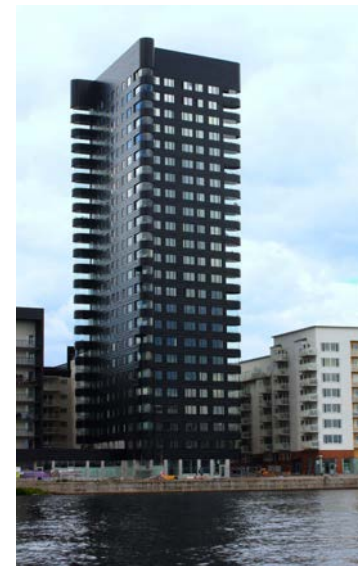
Årstadal, 22 våningar, 75 meter. Arkitekt: Wingårdhs.
