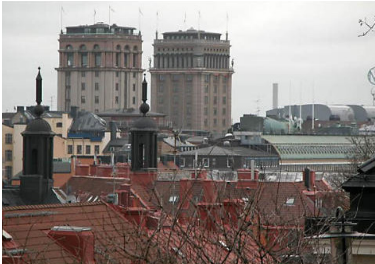
Kungstornen, 1924 - 1925. Var med sina 17 våningar/60 meter Sveriges högsta hus då de byggdes. Arkitekt: Sven Wallander
