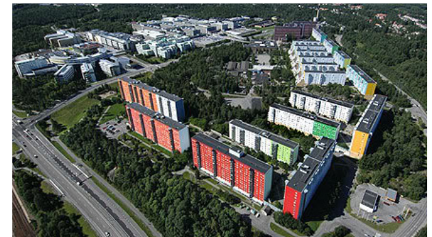
Västra Flemingsberg (Grantorp), 8-14 våningar. Området byggdes som en del av miljonprogrammet. De arton skivhusen är utförda i klara fasadfärger och de första husen blev färdiga 1973. Arkitekt: Ej känt. Foto: Okänt.
