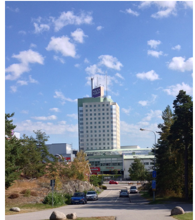
Nacka Forum: I dagsläget är det Nackas högsta byggnad med sina 16 våningar. Höghusdelen innehåller kontor och var klar 1989 då hela centrumanläggningen invigdes. Redan 1968 togs en första översiktsplan av området och planerna på ett stort, modernt köpcentrum i Nacka. Arkitekt: Gillberg Arkitekter. Foto: Christian Rydberg Dahlin.
