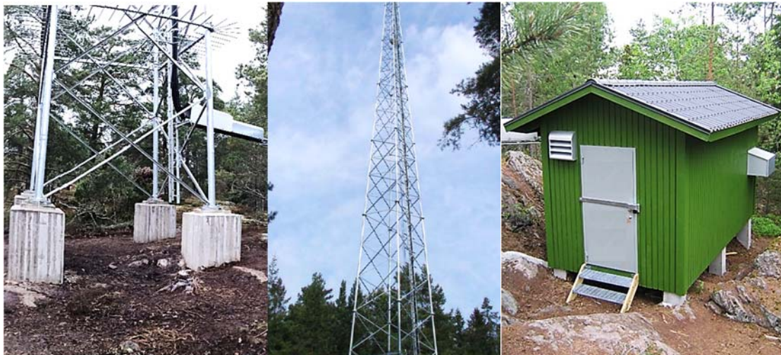
Bild till vänster visar exempel på mastfundament. Bild i mitten visar mobilmast i den masttyp som avses att uppföras. Bild till höger visar utformning av teknikbodarna som verksamhetsutövaren avser att uppföra. (bildkälla: Hi3G)
