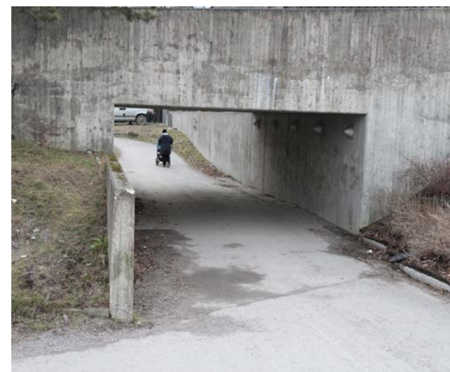
Gång- och cykeltunnel vid panncentralen
