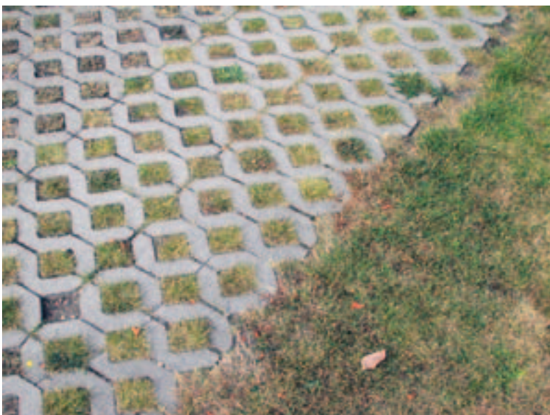
Bild 5. Parkeringsyta med hålsten av betong. En långsiktigt hållbar dagvattenhantering, 2004.
