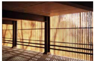
Parking Garage / Birk Heilmeyer und Frenzel Architekten
