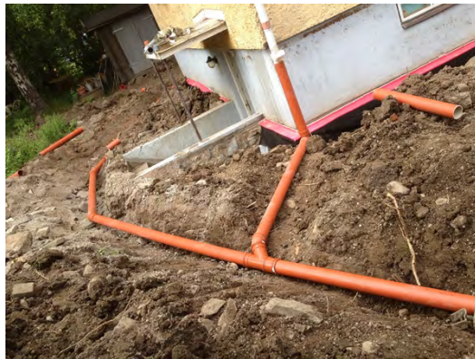
Bild 4. Dagvattenledningarna från stuprören till kassetten i gräsmattan
