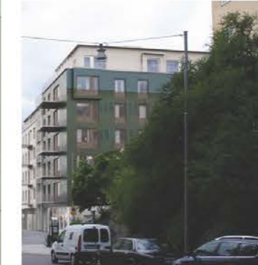
Referens grön plåtfasad KV to-baksmonopolet
