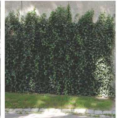
Spaljé framför sockel fasad.
