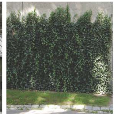
Spaljé framför sockel fasad.
