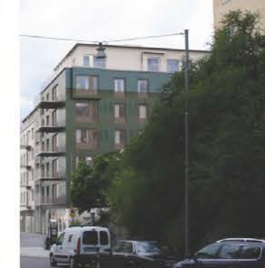
Referens grön plåtfasad KV to- baksmonopolet
