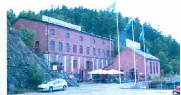
Befintliga tegelhus på kajen
