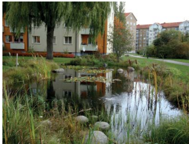
Dagvattenhantering med dagvattendamm, Sweco, dagvattengruppen
