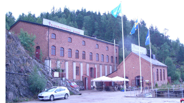
Befintliga tegelhus på kajen
