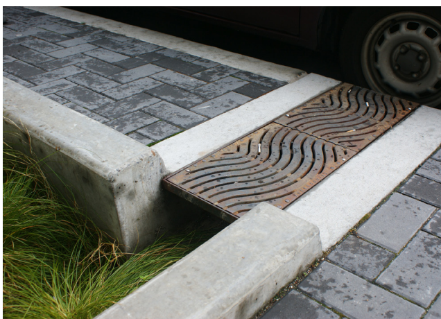
Referensbild, SWECO, dagvattenhantering, vattenränna
