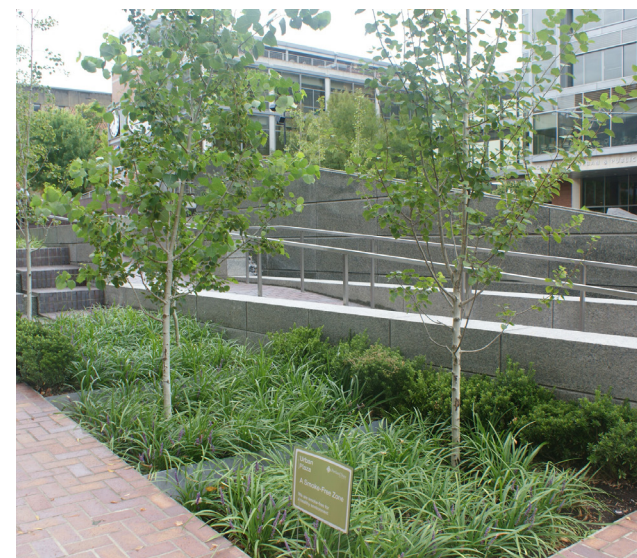
Referensbild, SWECO: Tillgänglighetsanpassad trappa med grönska och dagvattenhantering.
