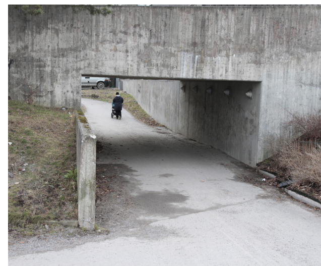
Gång- och cykeltunnel vid panncentralen
