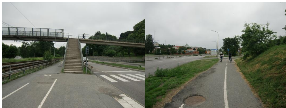
Figur 6. Finntorp, punkt 10 och 11 bild t.v. och Järlakrysset punkt 12-16 t.h. (Foto: Sweco)
