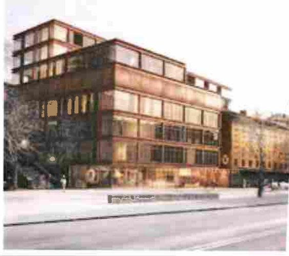
Byggstart för ett nytt Ersta sjukhus är planerad till 2017.
