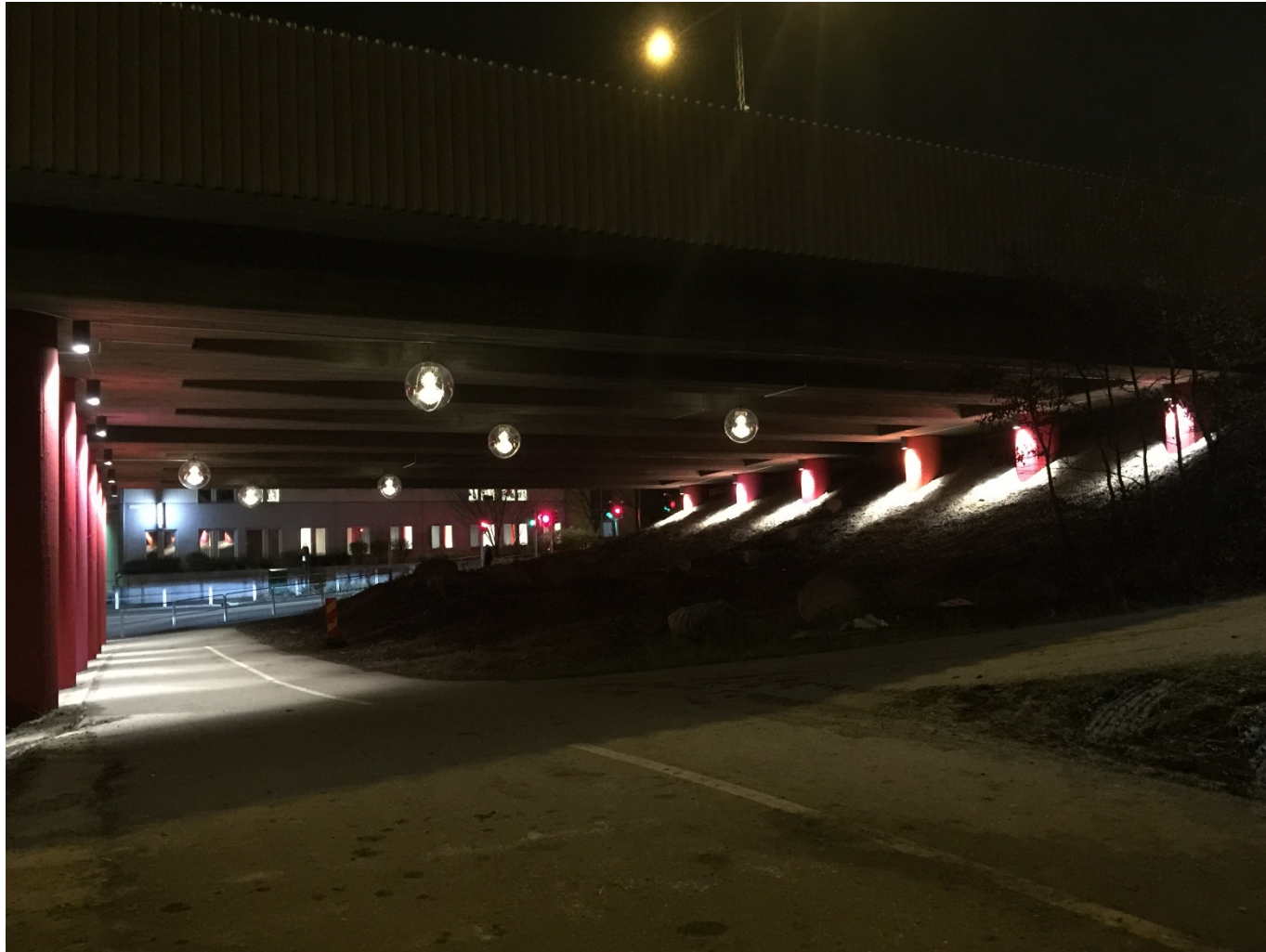
*Inverness viadukt - Danderyd
