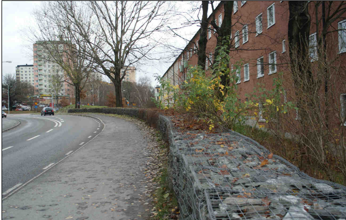
Figur 16: Gabionmur och träd Foto: Johan Nilsson
