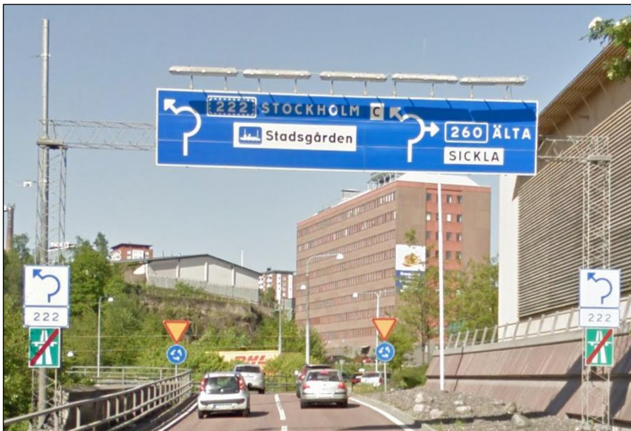
Figur 6: Befintlig vägvisningsskylt på Södralänkens avfart ramp
