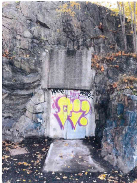
Figur 11: Dörr till ett mindre bergrum med Atrium Ljungberg som förvaltare.
