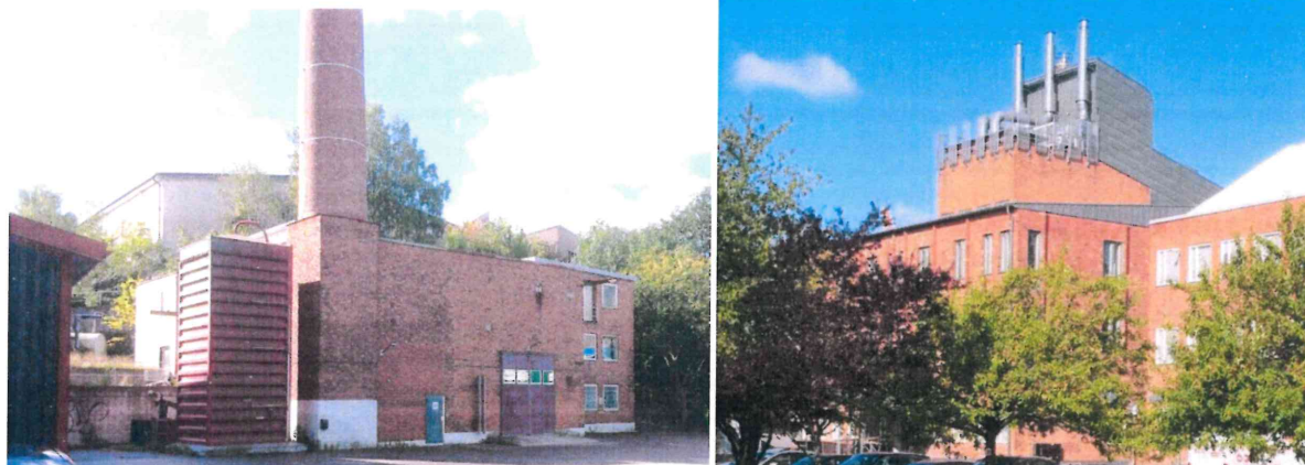
Figur 9: Panncentralens fasad mot norr t.v. och Formalinfabriken t.h. vid platsbesök 2017-09-07.
