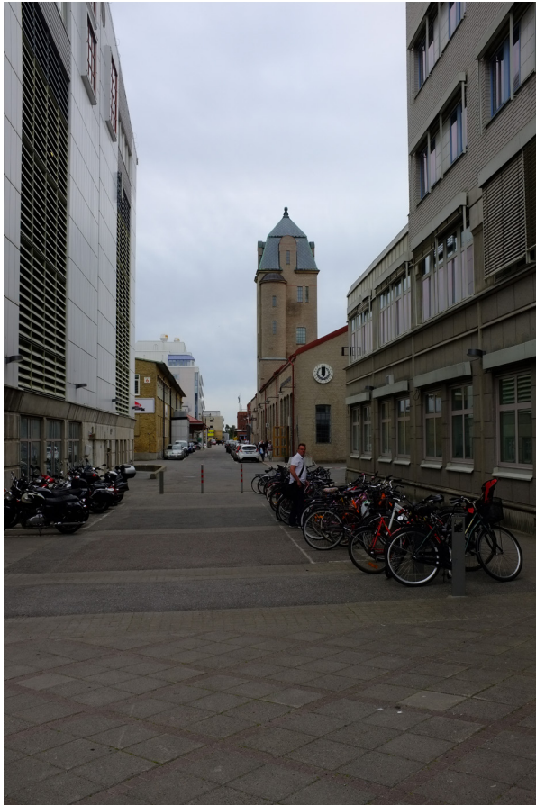
Figur 56. Den äldre delen av Slakthusområdet kring stationsentrén mot Rökerigatan.
