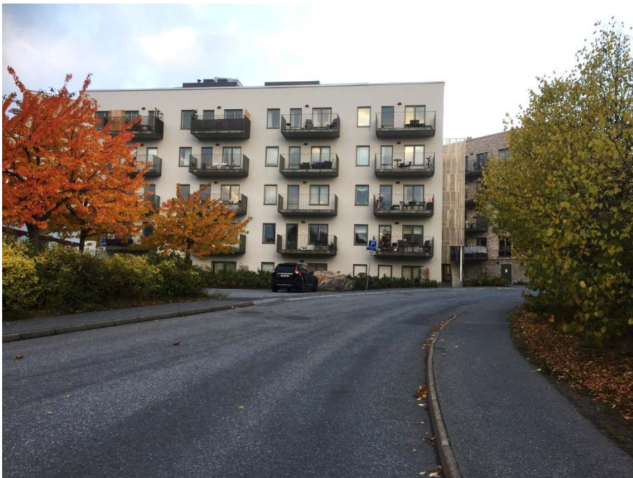
Vy från Fyrspannsvägen, mot nordväst, efter utbyggnad.
