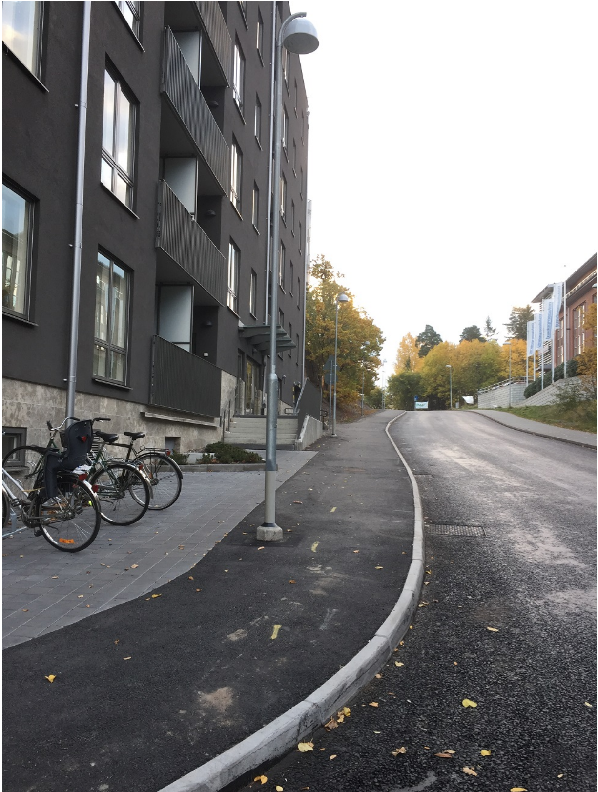
Ny gångbana/ trottoar med belysning
