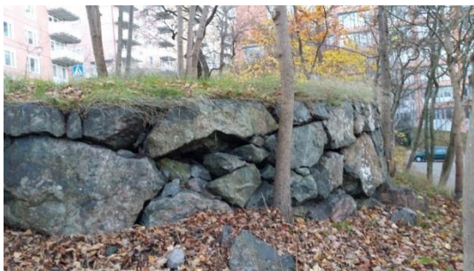
Bild 8. Stenmur pågående ras och förskjutning noteras
