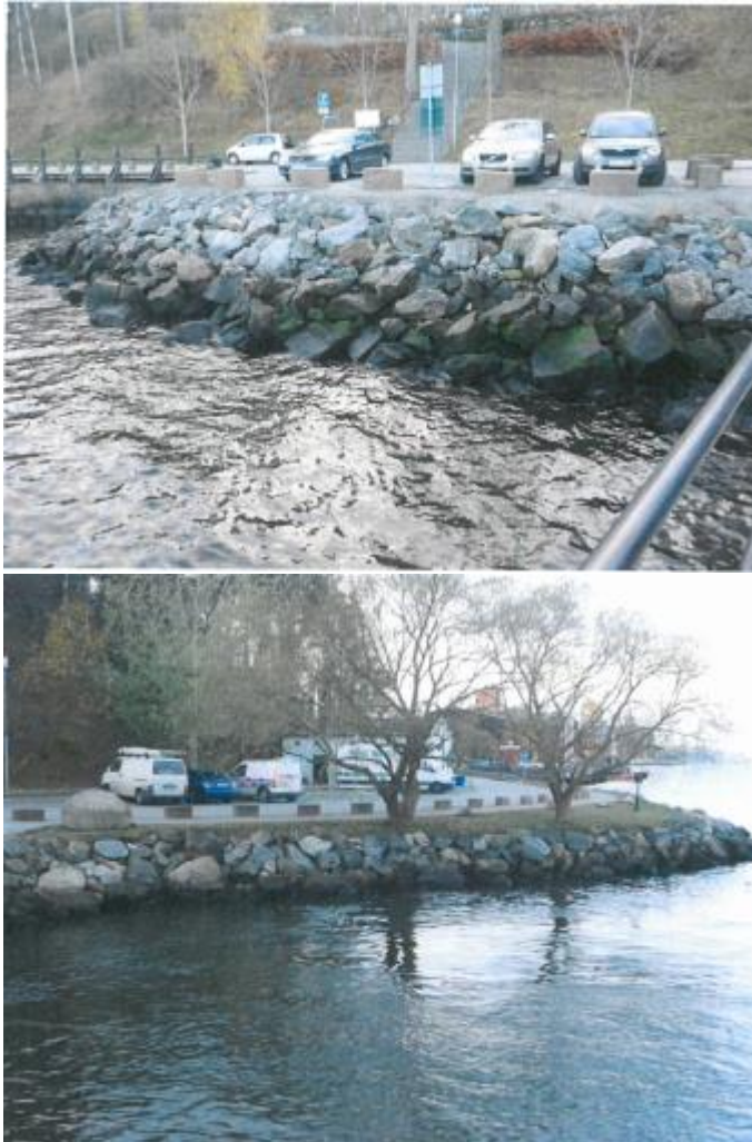
Bild 15. Strandskoning lagd med granitblock.
