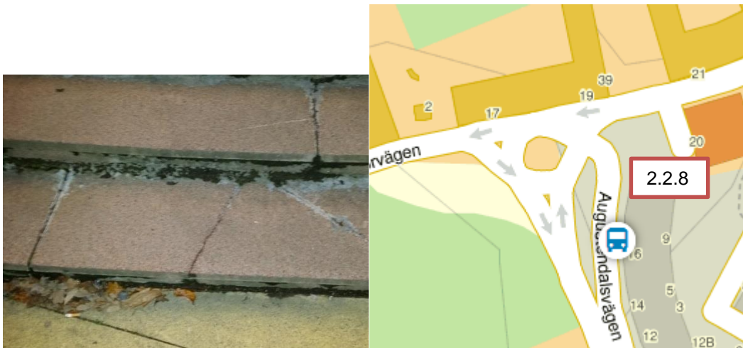
Bild 10. G6 Trappa, sprickor i sten
