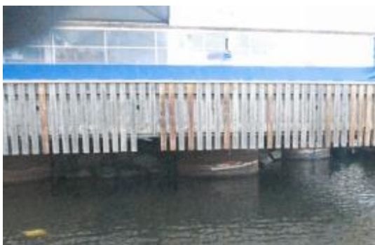
Bild 18. Stenfyllning under pelarkaj.
