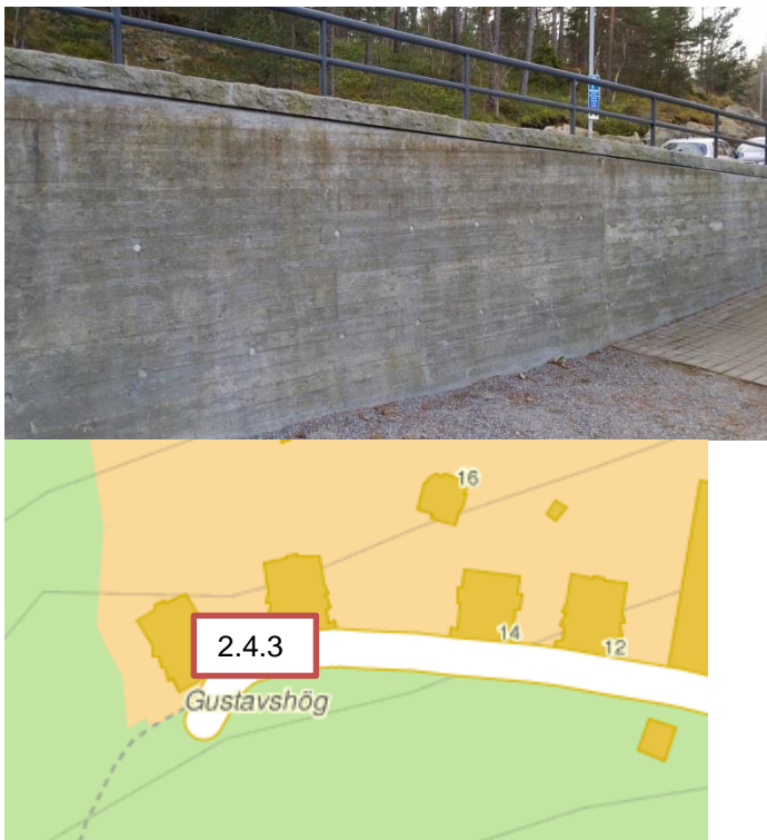
Bild 30. Stödmur intill Brf Gustafshög
