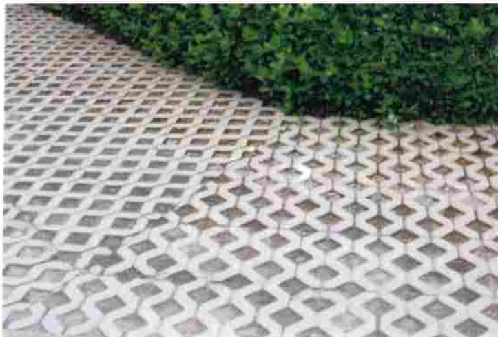
Figur 13. Hålsten/betongraster med sand i Växjö. Källa: Sweco
