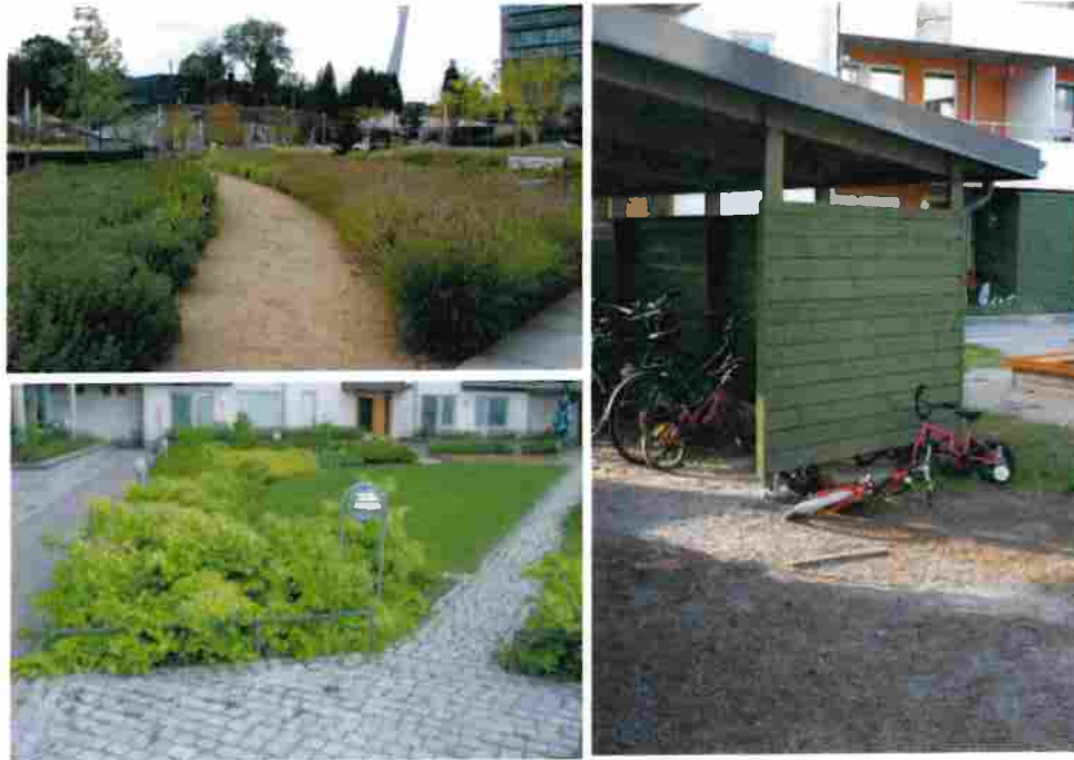
Figur 10. Exempel på permeabla beläggningar i form av grus/sand och små gatstenar.
