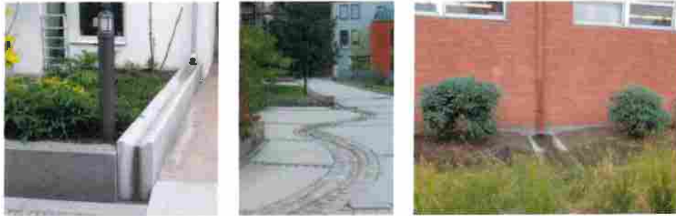
Figur 9. Bilderna ger exempel på stuprörsutkastare som ansluter till rännor samt olika typer av rännor.
