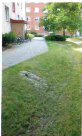
Figur 20. Svackdike längs gångväg. Källa: Sweco.
