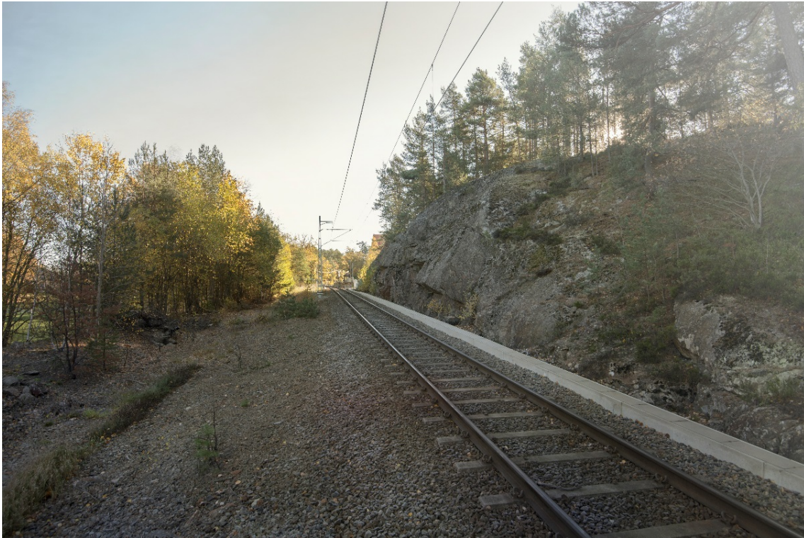
Dagens enkelspår, vy från väster. Till vänster ses befintlig slänt av krossmaterial. Till höger ses nuvarande bergskärning. Foto av Sweco.
