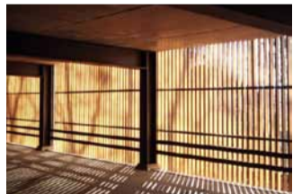
Parking Garage / Birk Heilmeyer und Frenzel Architekten
